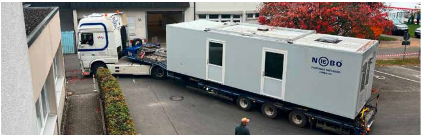
Während des Umbaus der Spülküche diente dem Team unter anderem ein Container als Arbeitsort.
